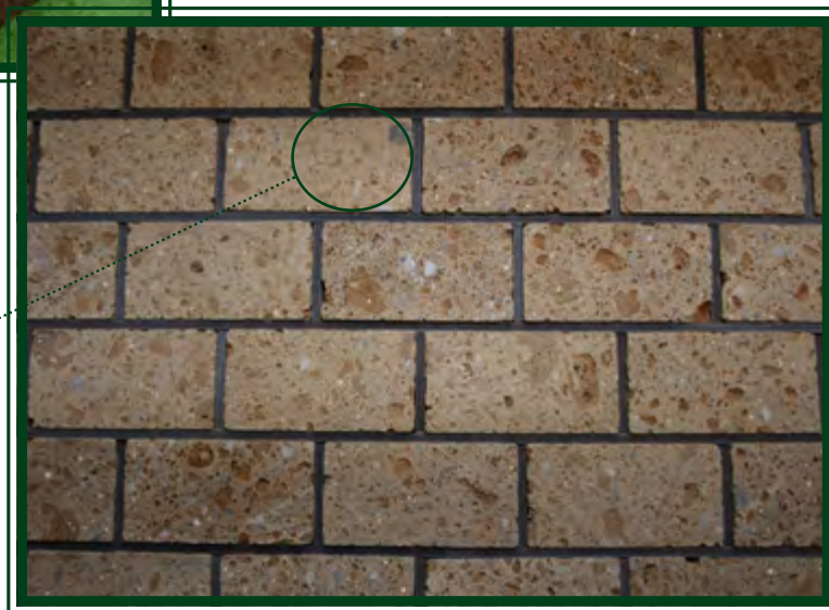
Rivestimenti con mattoncini con Fuga
